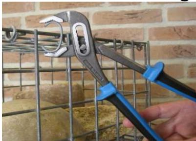
Es wird empfohlen die Steinkörbe zuerst aufzustellen und miteinander zu verbinden. Dies können Sie mit der mitgelieferten Rohrzanze und den C-Ringen tun. Damit können Sie ebenfalls den Deckel verschließen.
