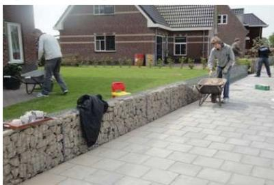
Sie haben alle Haken befestigt und können nun mit dem Befüllen der Körbe beginnen. Die kleineren Bruchsteine können Sie einfach in die Körbe werfen, aber die großen Steine müssen Sie von Hand in die Körbe legen. Sie erzielen das beste Ergebnis, wenn Sie die Bruchsteine mit der flachen Seite gegen die Außenwand des Korbes legen. Nach dem Befüllen der Körbe schließen Sie den Deckel, indem Sie an allen drei Löchern einen C-Ring anbringen.
